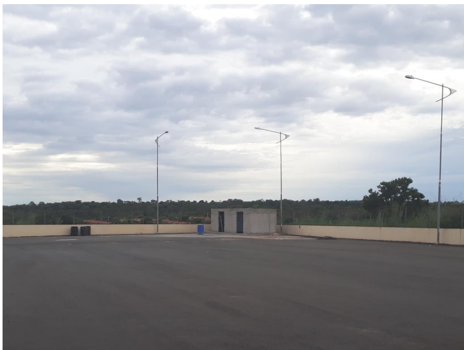
Figura 5: Depósito de lixo (em construção)
