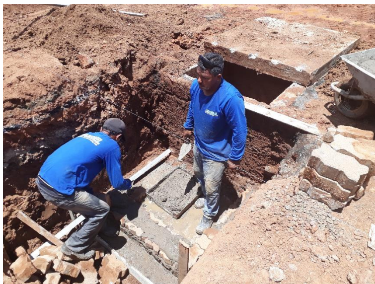
Figura 18: Caixa Passagem Esgoto
