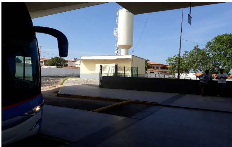
Figura 04: Construção dos Banheiros
