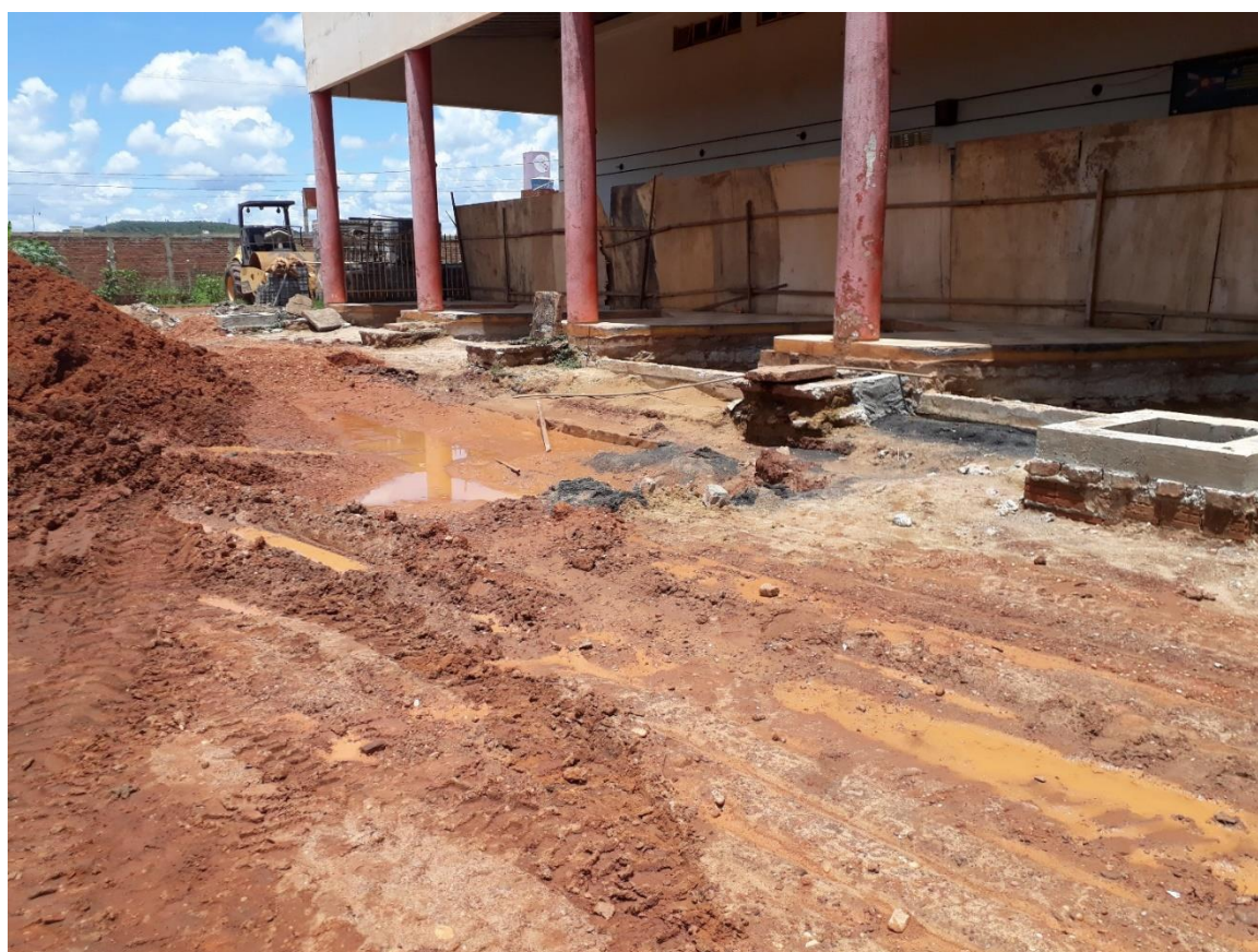
Figura 18: Caixa Passagem Esgoto
