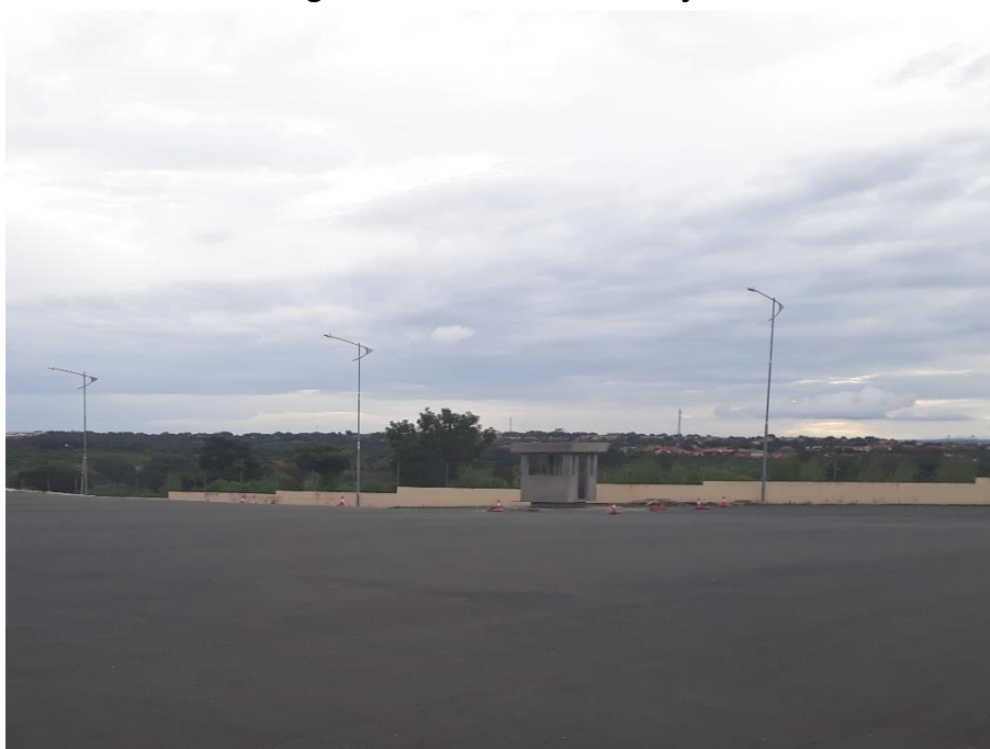
Figura 6: Guarita em construção
