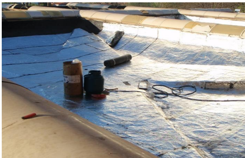
Figura 18: Impermeabilização das pétalas
