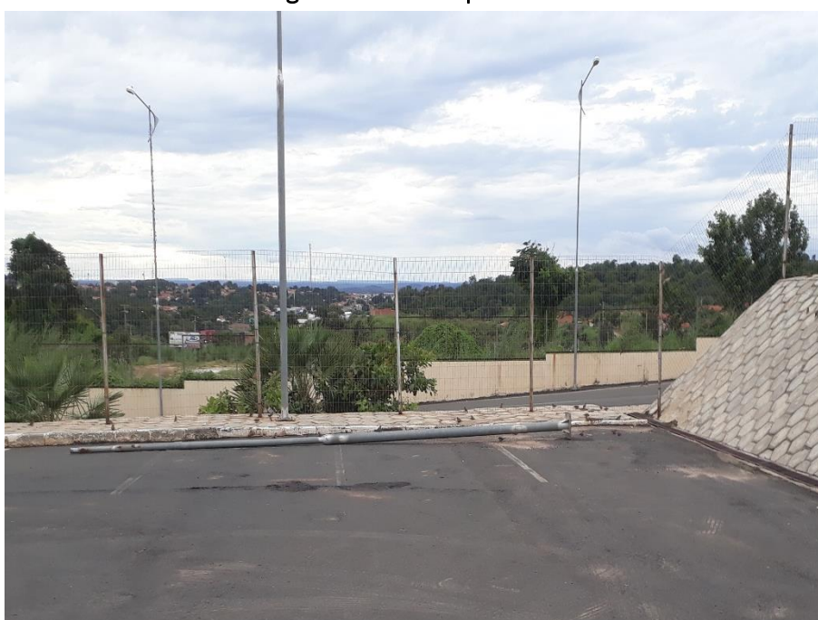
Figura 10: Poste quebrado
