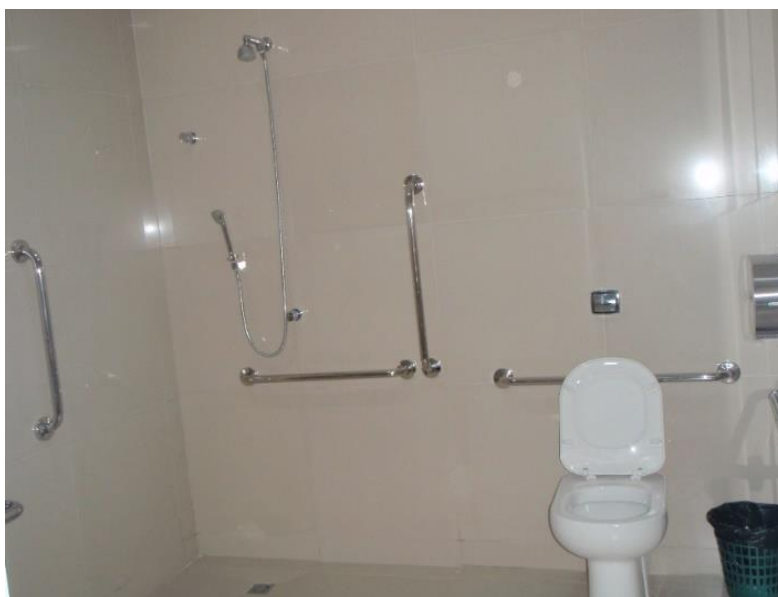
Figura 12: Banheiro PNE do Térreo
