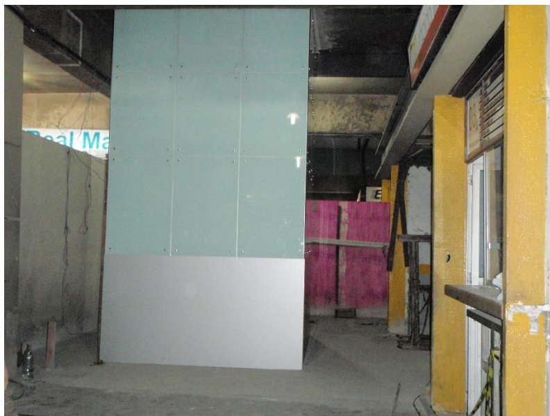
Figura 02: Painéis de revestimento do Elevador – Térreo
