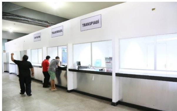
Figura 05: Nova Fachada dos Guichês de Atendimento aos usuários
