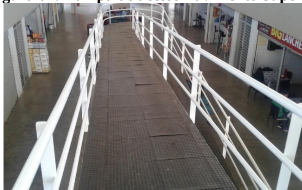
Figura 04: Rampa de acesso Pavimento Superior
