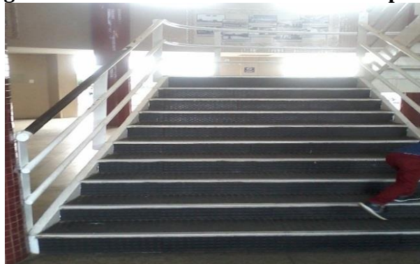
Figura 03: Escada de acesso Pavimento Superior
