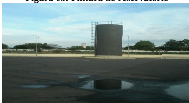
Figura 05: Pintura do reservatório
