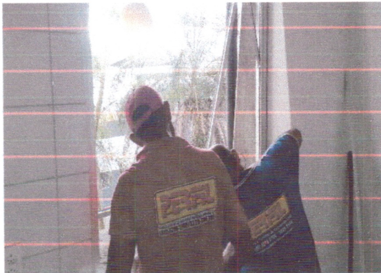
Troca das Esquadrias.
