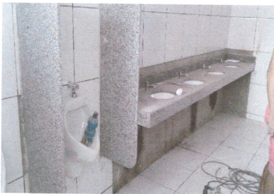
Sanitário da Plataforma de Embarque.
