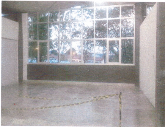
Instalações das Esquadrias.
