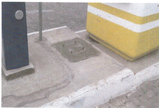
Cobertura da Guarita.
