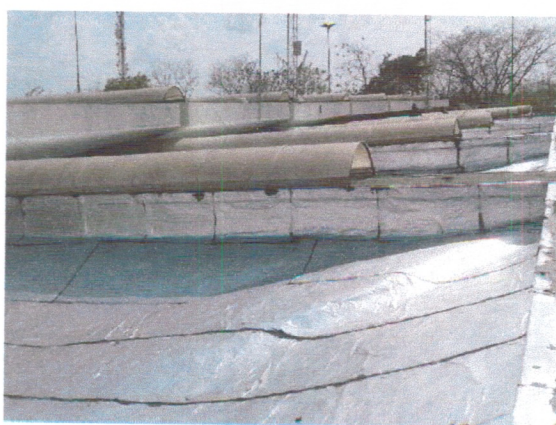
Impermeabilização pétalas do teto.
