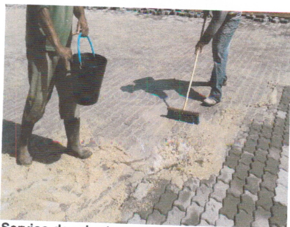
Serviço de rejunta do Piso.
