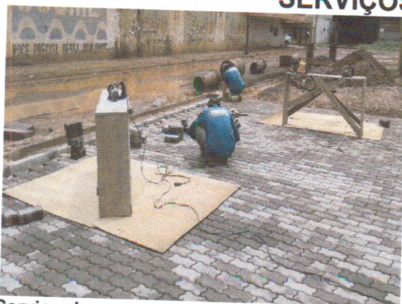
Serviço de assentamento do piso.
