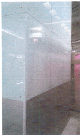
Instalação do elevador.
