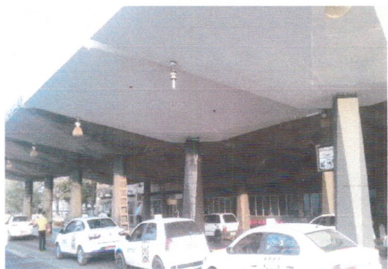
Pintura Geral do TR
