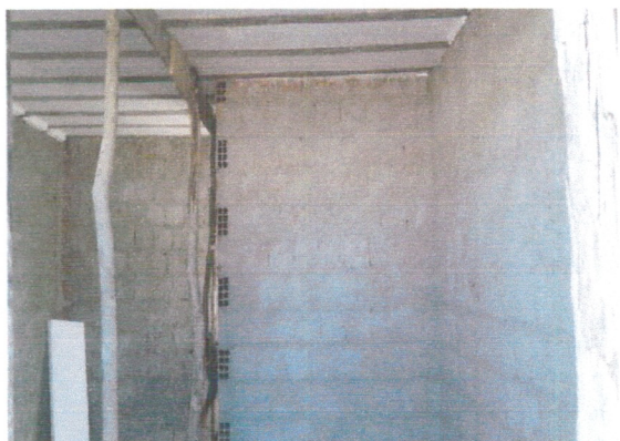
Sanitário da Plataforma de Embarque
