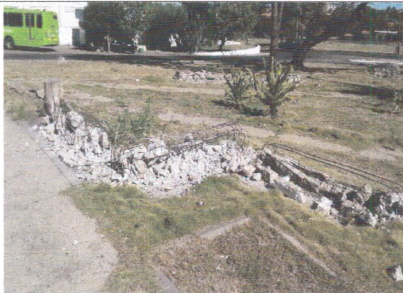
Recuperação da Área Externa
