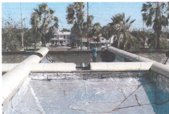
Impermeabilização pétalas do teto.
