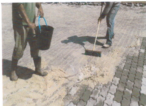
Serviço de rejuntamento do Piso.
