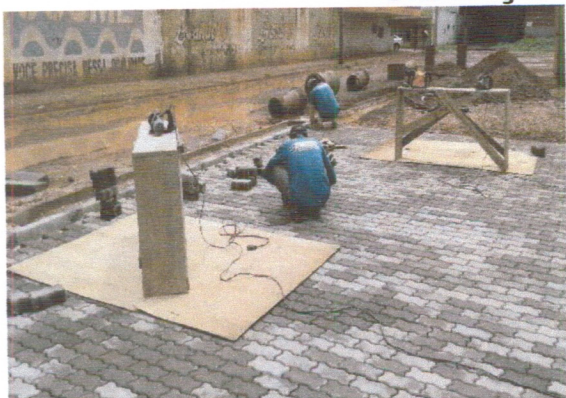
Serviço de assentamento do piso.
