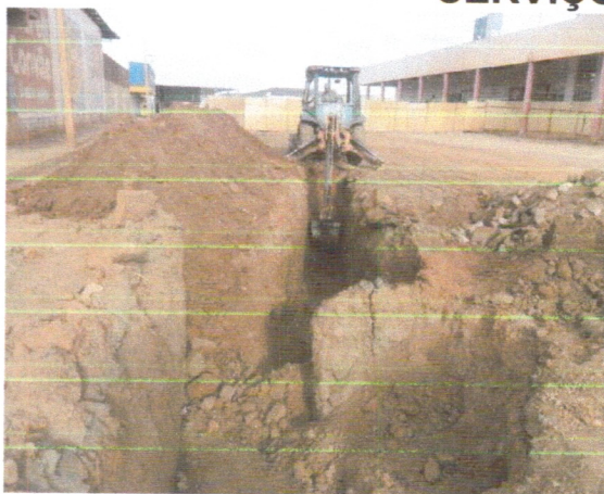
Escavação de valas.
