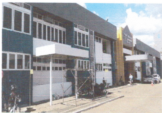
Conclusão dos serviços.
