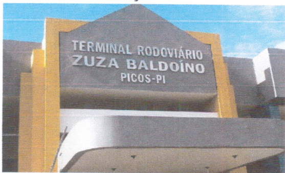
Instalação do letreiro.
