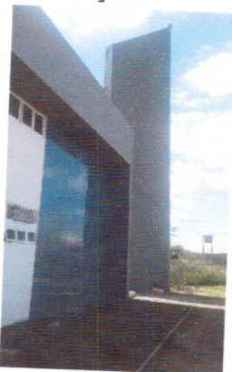
Conclusão dos serviços.
