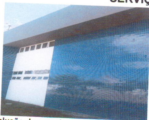
Conclusão dos serviços.
