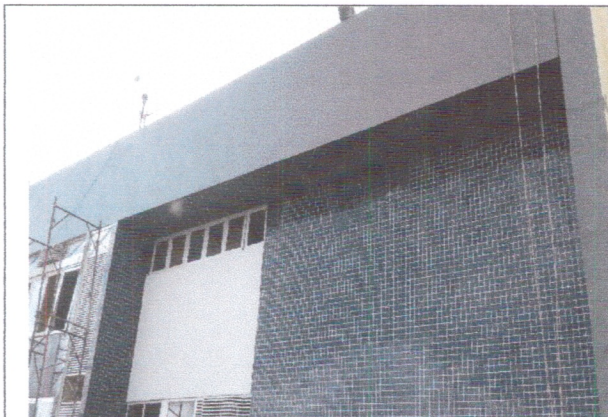
Reforma Fachada Principal.
