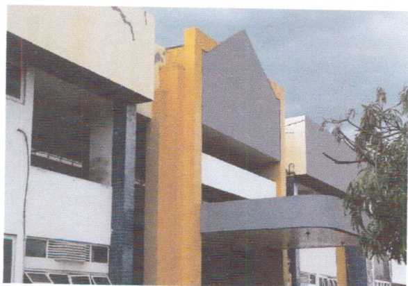
Reforma Fachada Principal.
