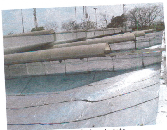
Impermeabilização pétalas do teto.
