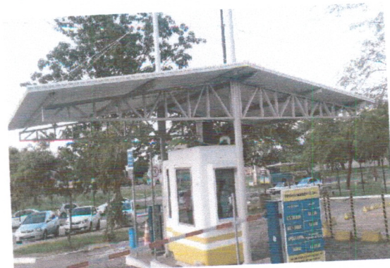
Cobertura da Guarita.
