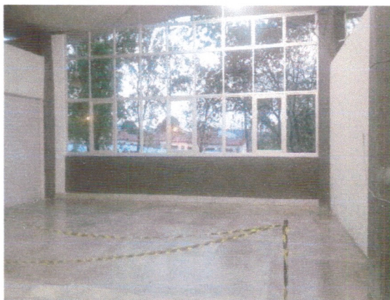
Instalações das Esquadrias.
