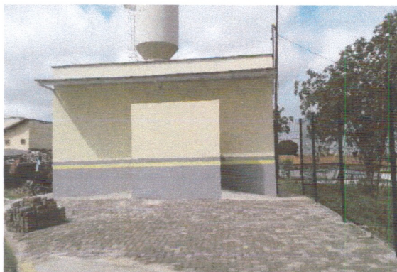
Sanitário da Plataforma de Embarque.
