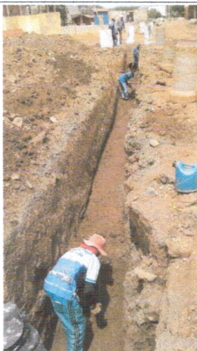
Escavações ETAPA II.
