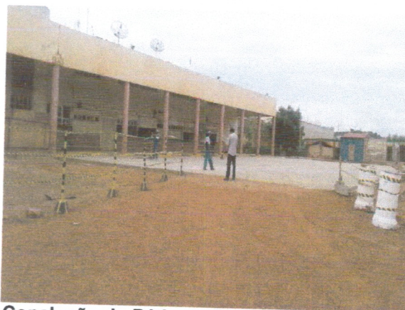
Conclusão do Pátio de Manobras.
