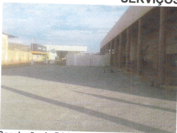
Conclusão do Pátio de Manobras.
