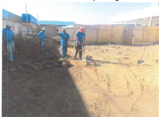
Remoção do piso do pátio de manobras.
