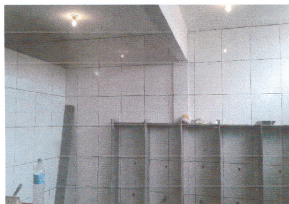
Serviço de revestimento cerâmico.
