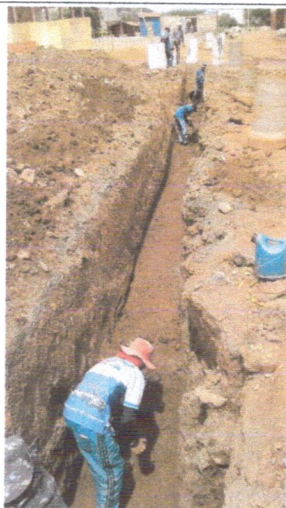
Escavações ETAPA II.
