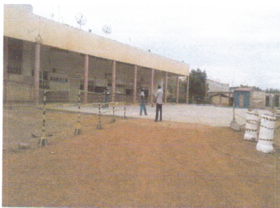
Conclusão do Pátio de Manobras.
