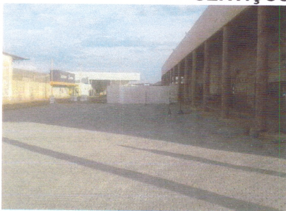
Conclusão do Pátio de Manobras.
