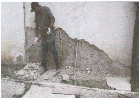
Reforma Fachada Principal.
