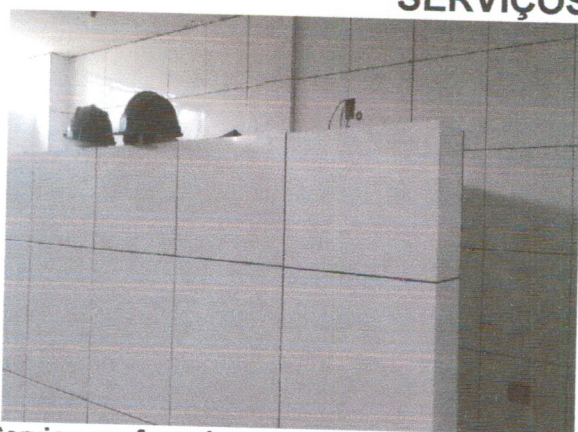
Serviço em fase de conclusão.
