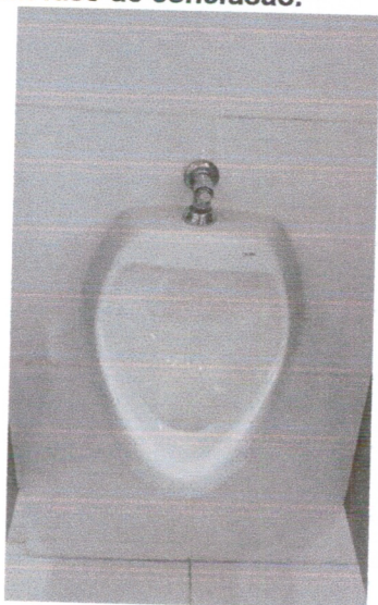
Serviço em fase de conclusão.
