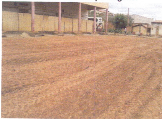
Terraplanagem do pátio de manobras.
