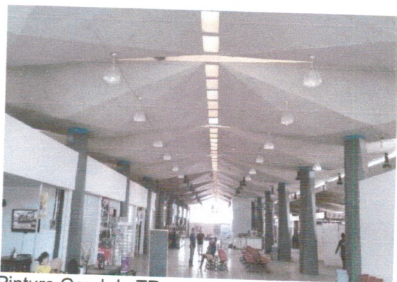
Pintura Geral do TR
