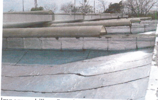
Impermeabilização pétalas do teto.
