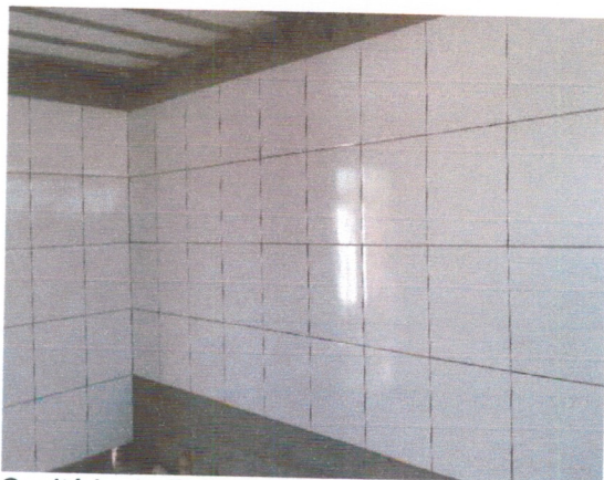
Sanitário da Plataforma de Embarque.
