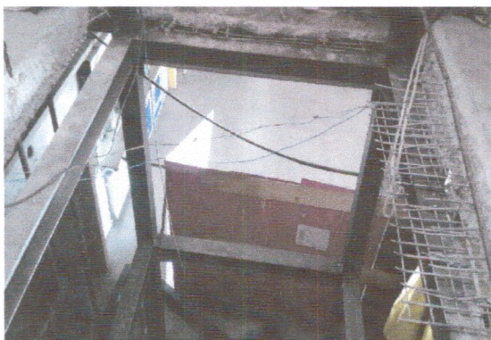
Instalação do elevador.
