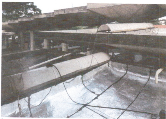
Impermeabilização pétalas do teto.
