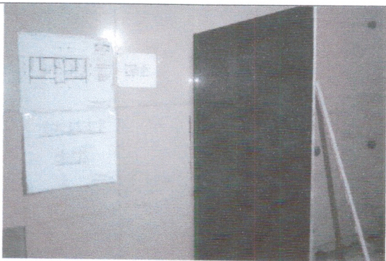
Sanitário Pav. Superior.
