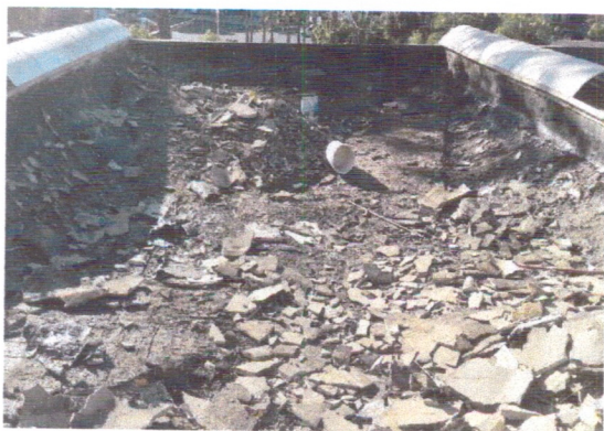
Impermeabilização pétalas do teto.
