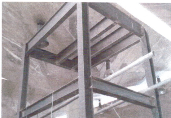
Instalação do elevador.
