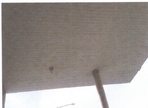
Serviço de recuperação de forro de PVC.
