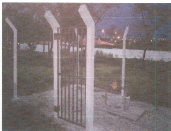
Proteção do poço tubular.
