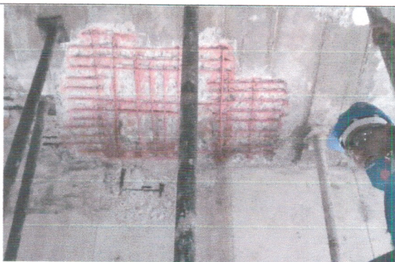
Recuperação Laje Sanitário.
