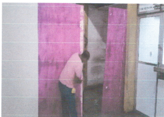
Isolamento da área do elevador.
