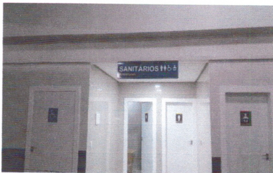
Sanitário Pav. Térreo.
