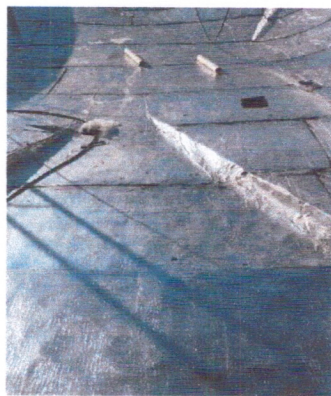
Impermeabilização pétalas do teto.
