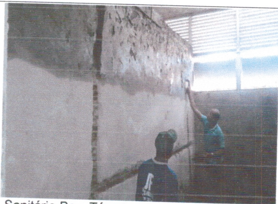
Sanitário Pav. Térreo.
