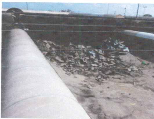
Impermeabilização pétalas do teto.
