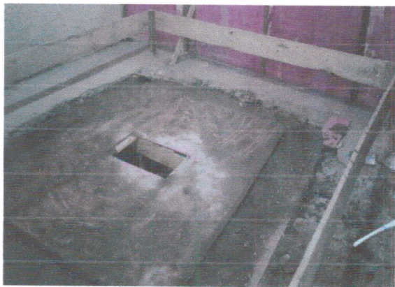
Instalação do elevador.
