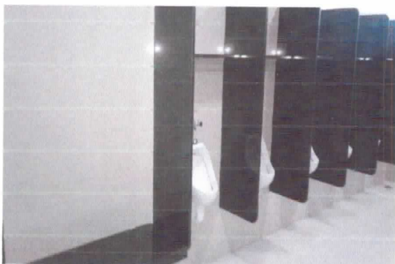
Sanitário (Pav. Térreo).
