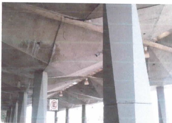
Drenagem da Cobertura.
