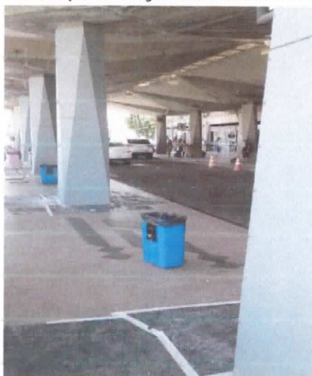
Área Externa (Pintura dos Pilares Entrada).
