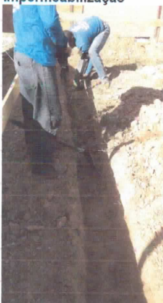
Sanitário Plataforma Embarque
