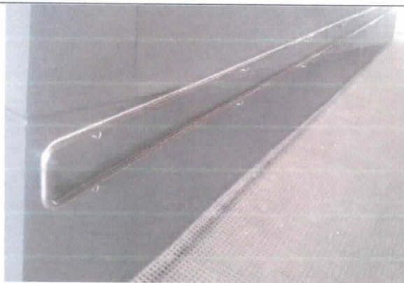
Instalação de Corrimão.
