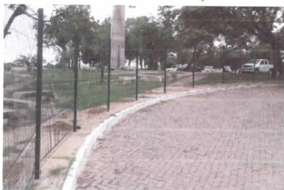
Estacionamento (Inst. Gradil)
