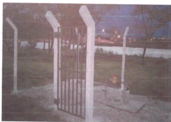
Proteção e Controle de potabilidade do Poço.
