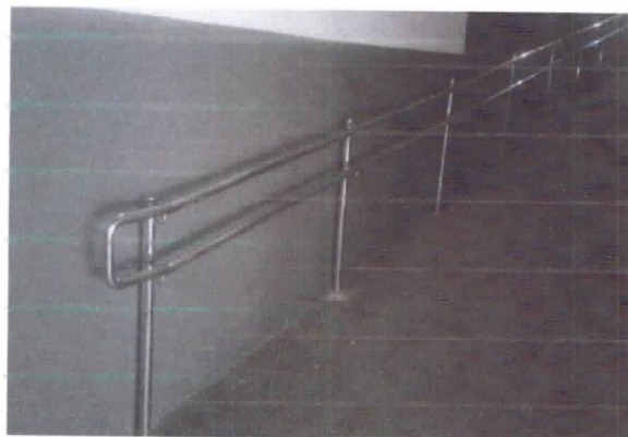
Instalação de Corrimão.
